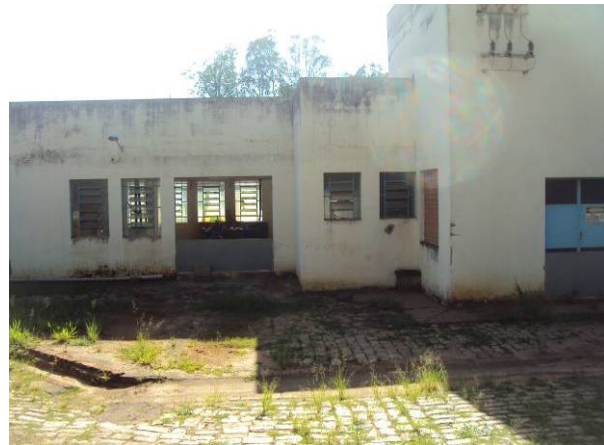
Figura 3.2.16. Vista da Casa de Bombas 02
