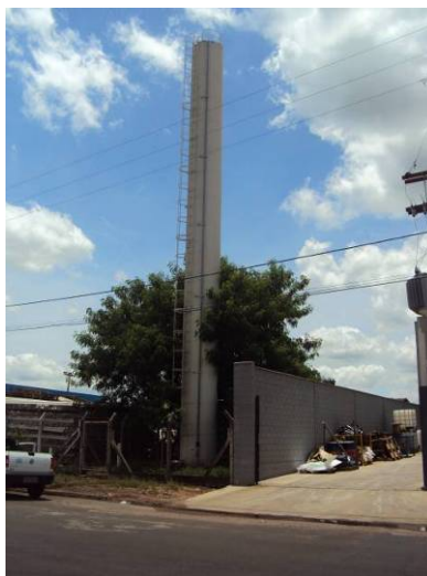
Figura 3.2.85. Vista do Reservatório Expresso
