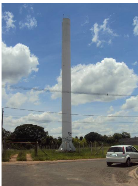
Figura 3.2.104. Vista do Reservatório Jardim Margarete
