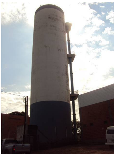
Figura 3.2.91. Vista do Reservatório Jardim Centenário
