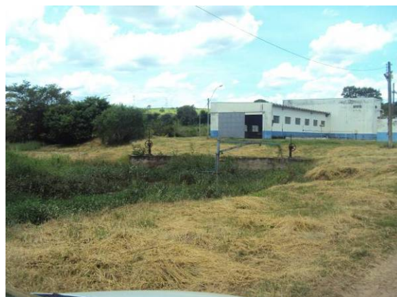
Figura 3.2.18. Vista da captação e casas de bombas
