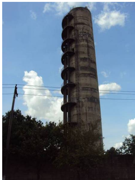
Figura 3.2.58. Vista do Reservatório Elevado
