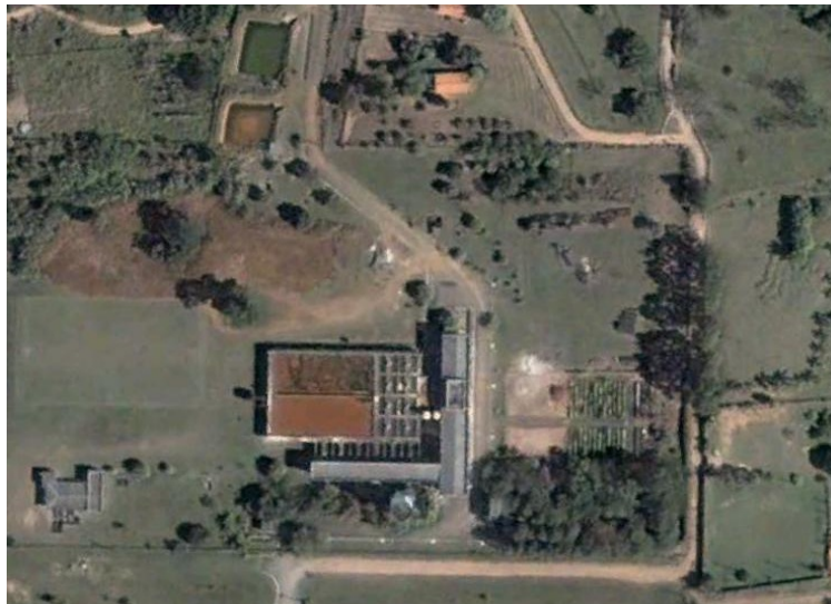
Figura 3.2.39. Vista da ETA II
