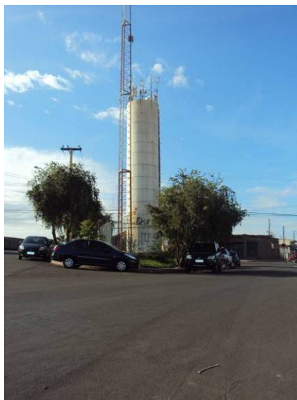
Figura 3.2.99. Vista do Reservatório Jardim Paineiras
