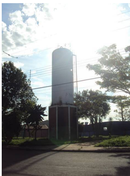
Figura 3.2.92. Vista do Reservatório Jardim Cidade Azul
