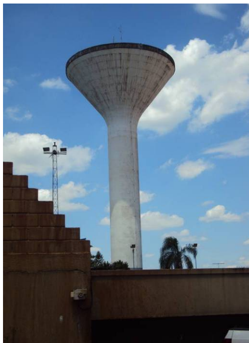
Figura 3.2.36. Vista do reservatório tipo elevado (Cálice)
