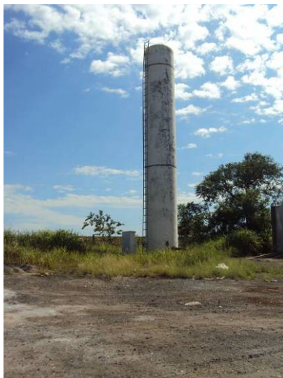
Figura 3.2.78. Vista do Reservatório do Distrito de Assistência
