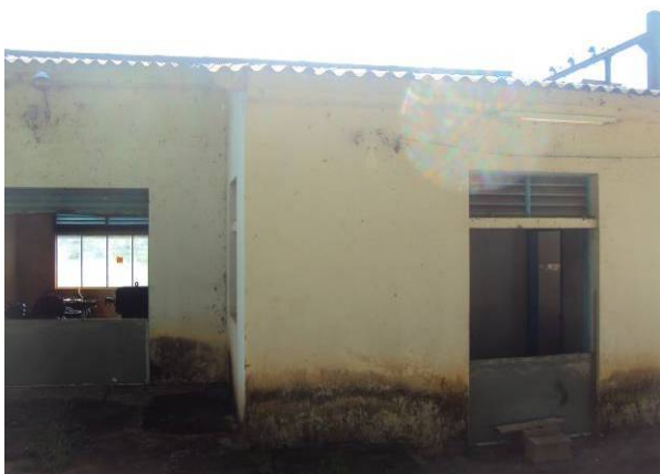
Figura 3.2.13. Vista da Casa de bombas 01
