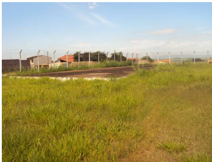
Figura 3.2.97. Vista do Reservatório Jardim Novo (Enterrado)
