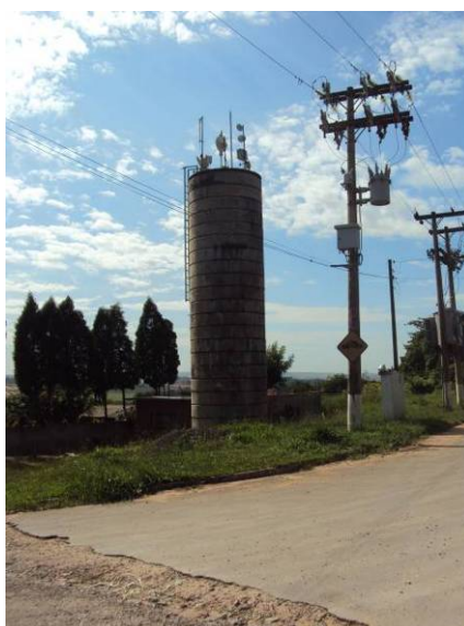
Figura 3.2.95. Vista do Reservatório Jardim Nova Rio Claro
