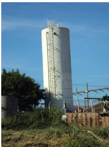
Figura 3.2.110. Vista do Reservatório Santa Elisa
