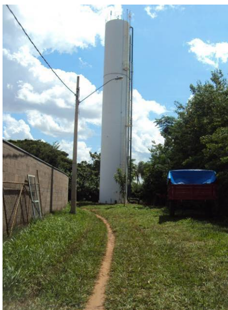
Figura 3.2.107. Vista do Reservatório Residencial Florença (Novo)
