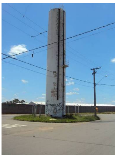
Figura 3.2.112. Vista do Reservatório Vila Verde
