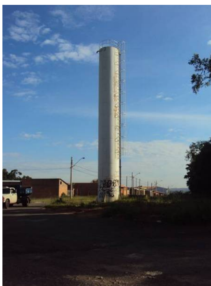
Figura 3.2.102. Vista do Reservatório Jardim Progresso II
