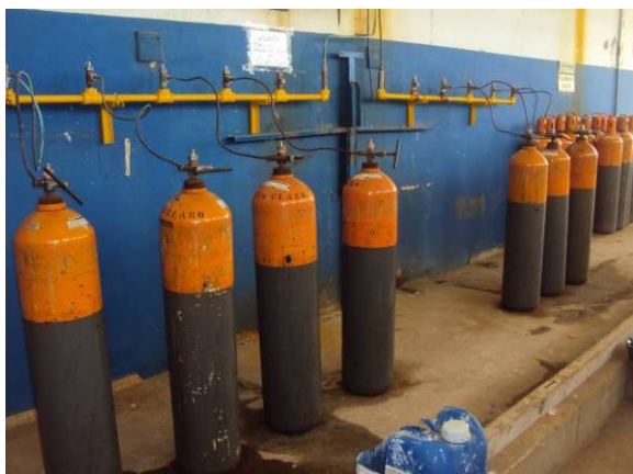
Figura 3.2.46. Vista dos Cilindros de Gás Cloro – Pré e Pós Cloração
