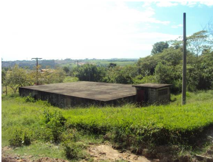
Figura 3.2.96. Vista do Reservatório Jardim Nova Rio Claro (Semi-Enterrado)
