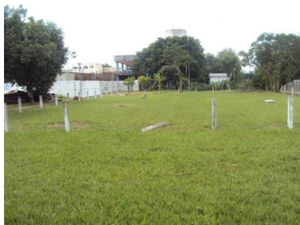
Figura 3.2.51. Vista do Reservatório Enterrado da ETA II
