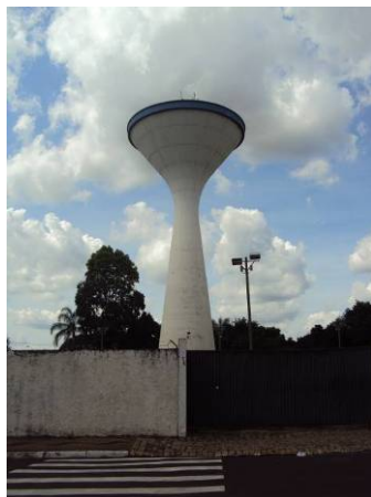
Figura 3.2.111. Vista do Reservatório Vila Martins
