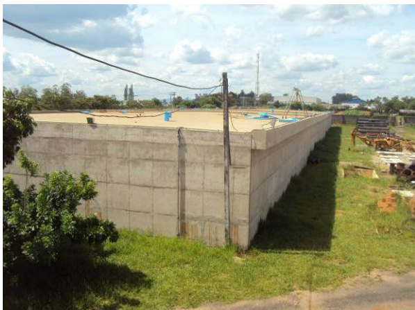
Figura 3.2.55. Vista do Reservatório apoiado
