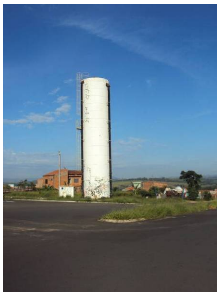
Figura 3.2.101. Vista do Reservatório Jardim Progresso I
