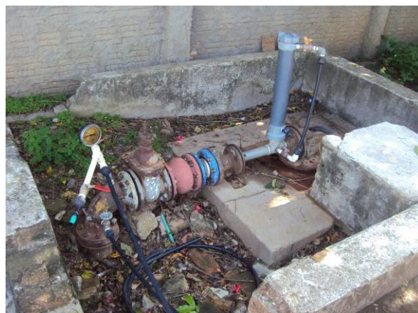
Figura 3.2.60. Vista do Poço
