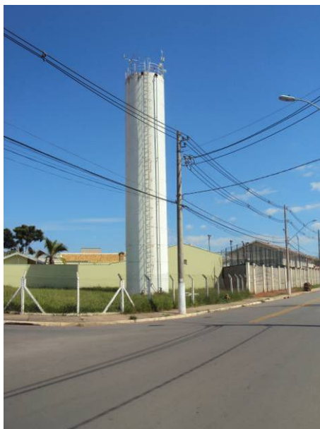
Figura 3.2.94. Vista do Reservatório Jardim Itapuã
