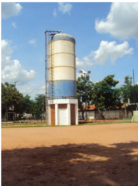
Figura 3.2.108. Vista do Reservatório Residencial Florença (Velho)
