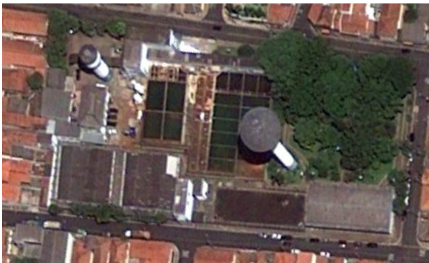
Figura 3.2.25. Vista da ETA I
