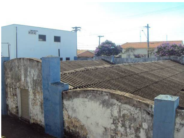
Figura 3.2.34. Vista dos reservatórios semi-enterrados
