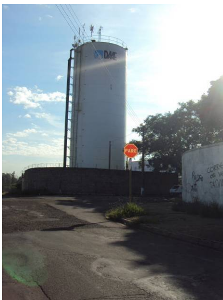
Figura 3.2.72. Vista do Reservatório Cervezão
