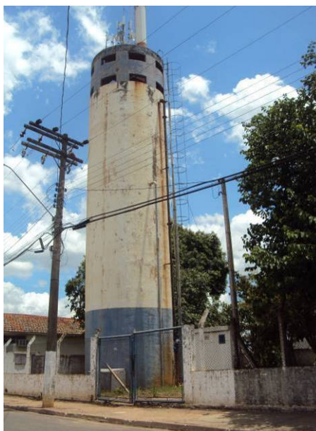
Figura 3.2.75. Vista do Reservatório de Ajapi
