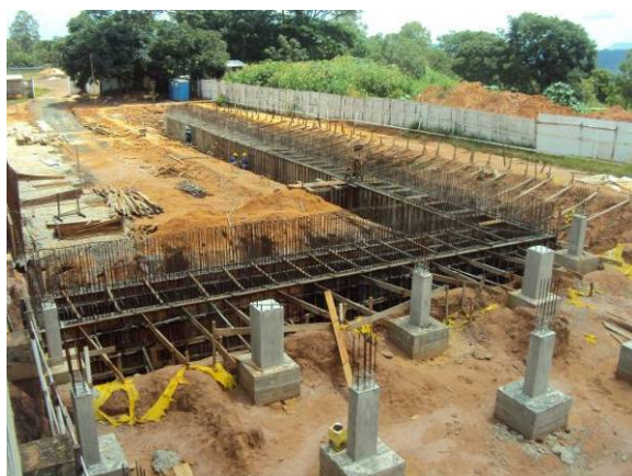
Figura 3.2.48. Ampliação da ETA II
