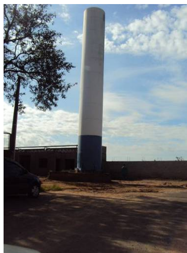
Figura 3.2.89. Vista do Reservatório Jardim Bom Sucesso
