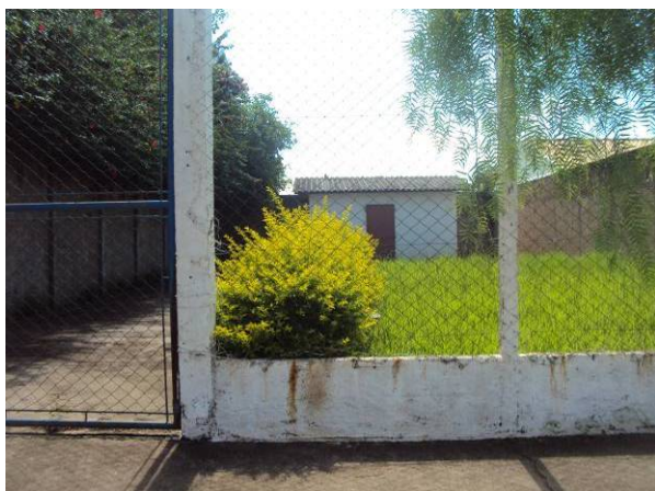
Figura 3.2.59. Vista do local do Poço
