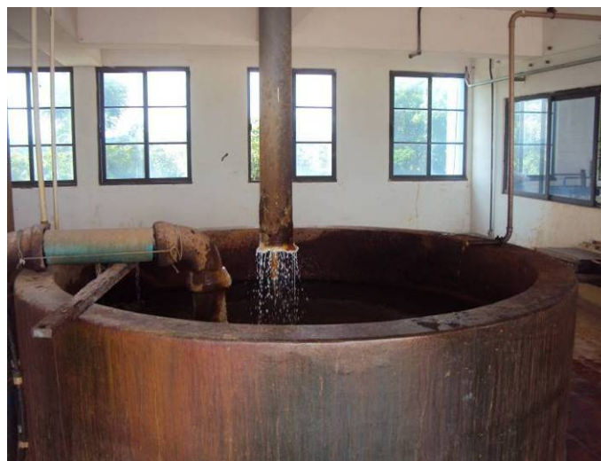
Figura 3.2.24. Vista da Caixa de chegada na ETA II
