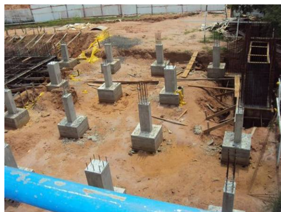
Figura 3.2.49. Ampliação da ETA II
