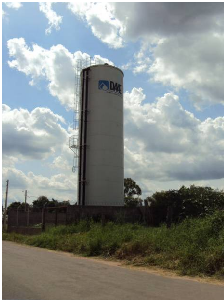
Figura 3.2.109. Vista do Reservatório Santa Clara
