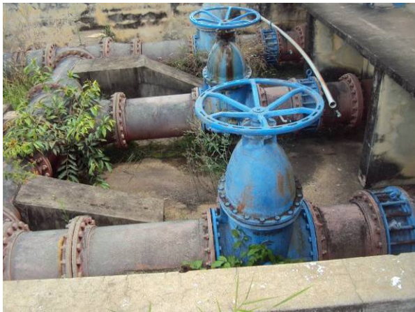
Figura 3.2.52. Vista da tubulação de chegada na Casa de Bomba n. 02
