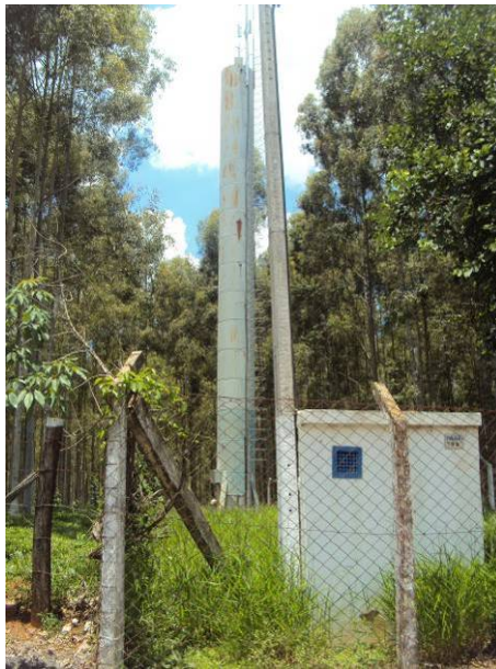
Figura 3.2.82. Vista do Reservatório Distrito de Ferraz
