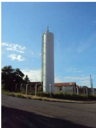
Figura 3.2.86. Vista do Reservatório Figueira
