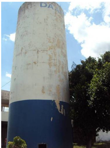
Figura 3.2.84. Vista do Reservatório Estrada Ajapi
