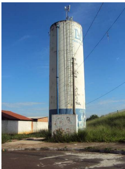
Figura 3.2.105. Vista do Reservatório Jardim Nosso Teto (Boa Vista)
