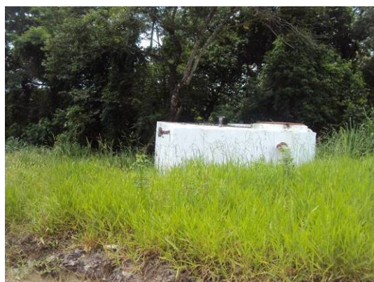
Figura 3.2.88. Vista do Reservatório Fontes e Bosques Alam Grai
