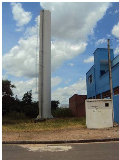
Figura 3.2.77. Vista do Reservatório Vila Di Napoli
