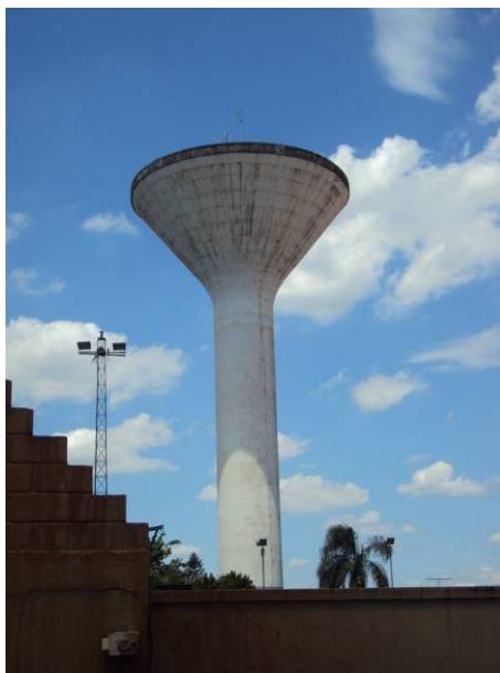
Figura 3.2.73. Vista do Reservatório Cidade Nova
