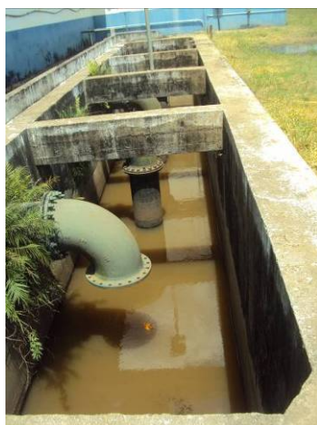
Figura 3.2.19. Vista do Poço de Sucção – Casa de Bombas n.º. 01
