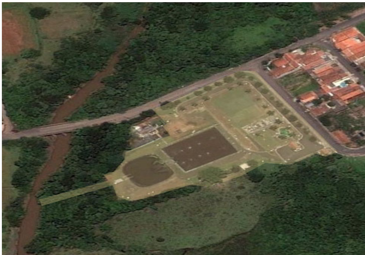
Figura 3.3.8. Vista da ETE Jardim Palmeiras
