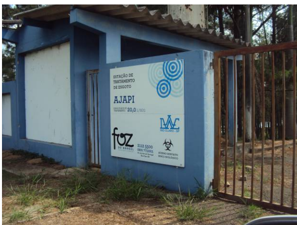
Figura 3.3.95. Vista da entrada da ETE Ajapi
