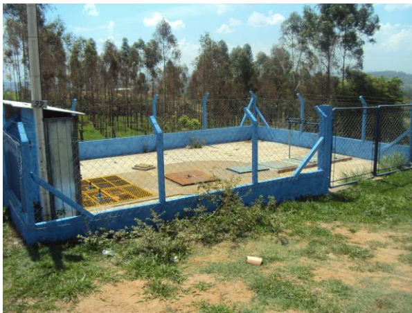
Figura 3.3.34. Vista da EEE Santa Clara II
