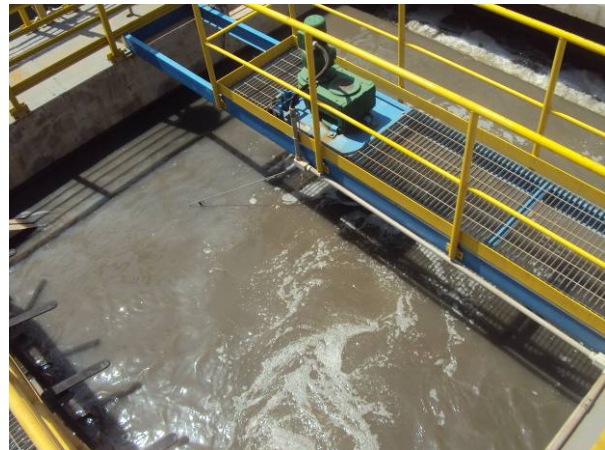
Figura 3.3.66. Vista do Tanque de chegada
