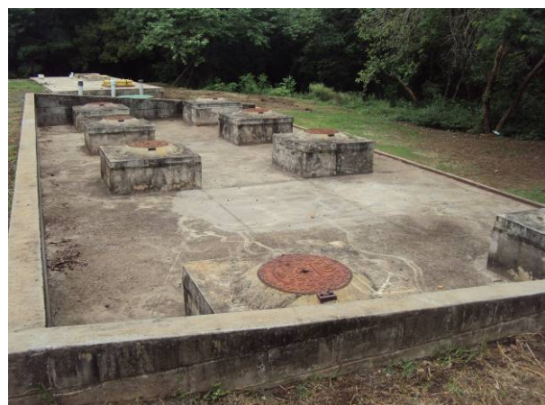
Figura 3.3.116. Vista do tratamento
