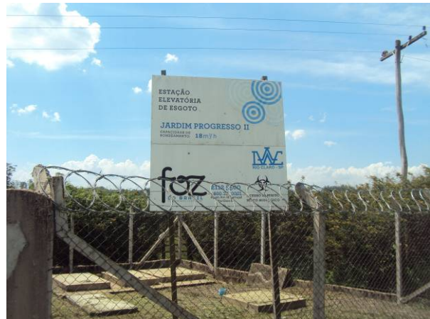
Figura 3.3.49. Vista da placa informativa da EEE
