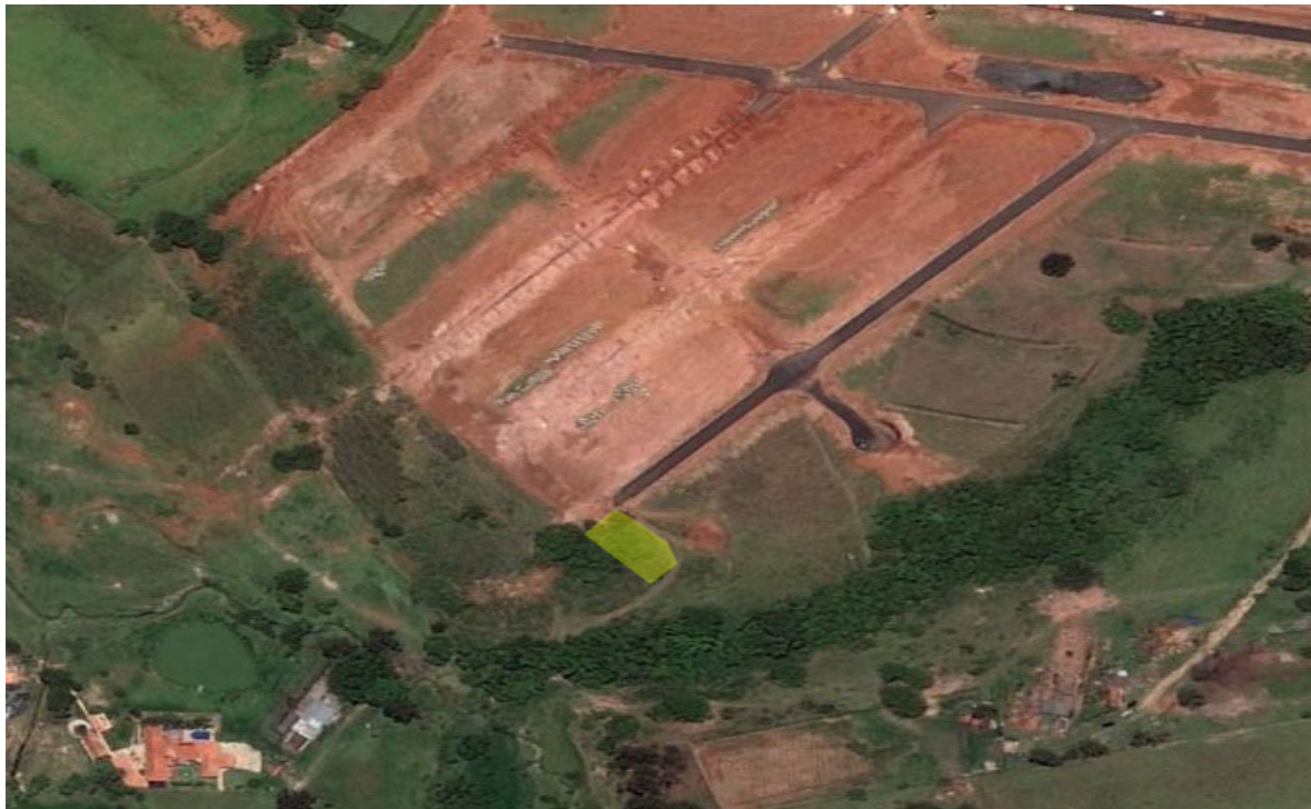
Figura 3.3.37. Vista do local da EEE
