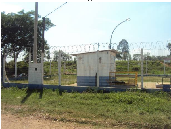
Figura 3.3.44. Vista da EEE Progresso I
