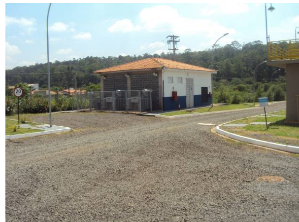
Figura 3.3.80. Vista da casa de energia
