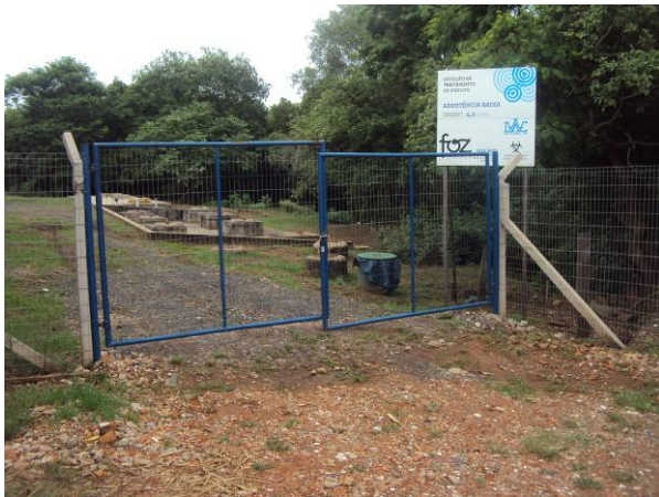
Figura 3.3.111. Vista da ETE
