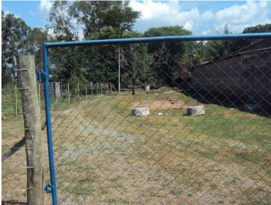
Figura 3.3.131. Vista da ETE
