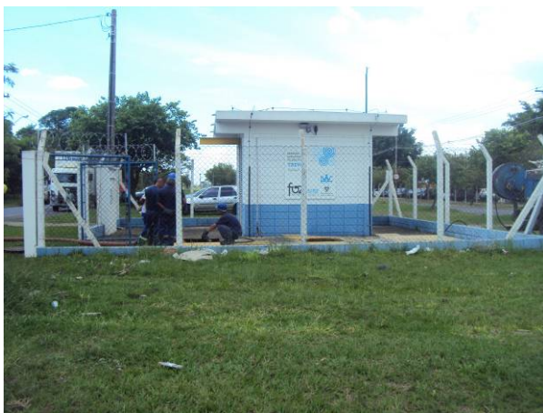
Figura 3.3.82. Vista da EEE Trevo
