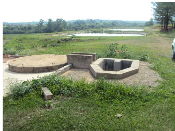
Figura 3.3.98. Vista das Caixas de distribuição
