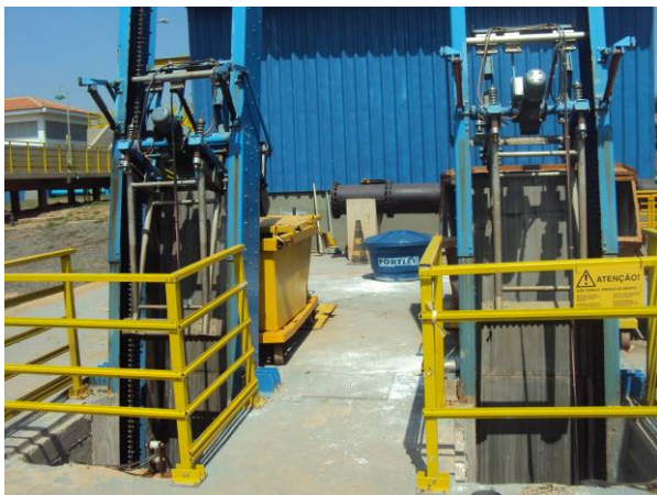
Figura 3.3.92. Vista do Peneiramento na chegada da EEE Conduta
