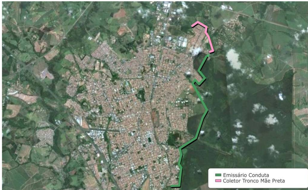
Figura 3.3.152. Vista do Coletor Tronco Mãe Preta até a EEE Vila Industrial
