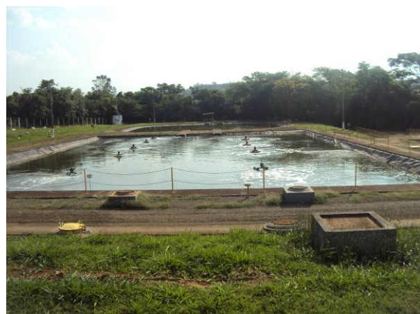
Figura 3.3.12. Lagoa de Aeração
