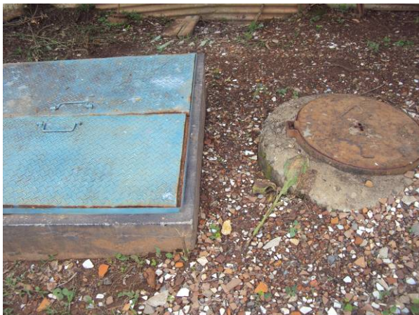
Figura 3.3.113. Vista do PV de chegada de esgoto
