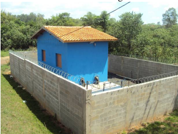
Figura 3.3.38. Vista da EEE Regina Picelli
