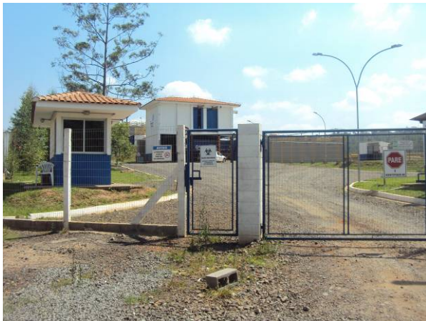
Figura 3.3.65. Vista da entrada da ETE Jardim Conduto
