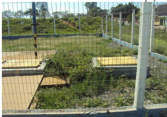
Figura 3.3.46. Vista da Chegada do esgoto
