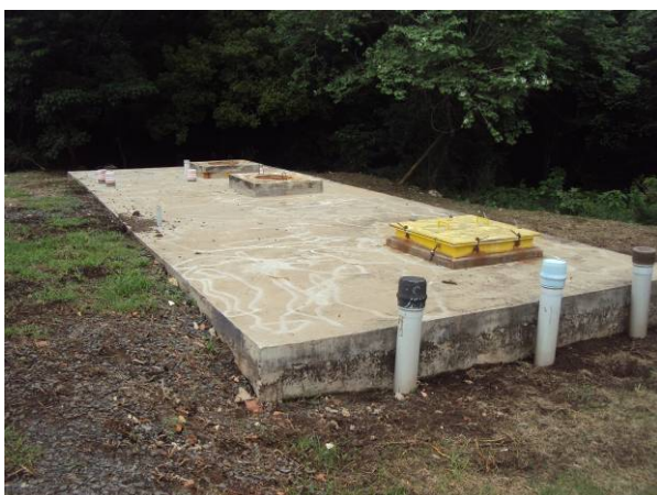
Figura 3.3.115. Vista do tratamento
