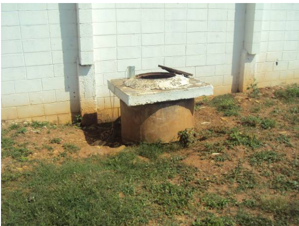
Figura 3.3.31. Vista do PV aonde são coletadas amostras do Efluente Final
