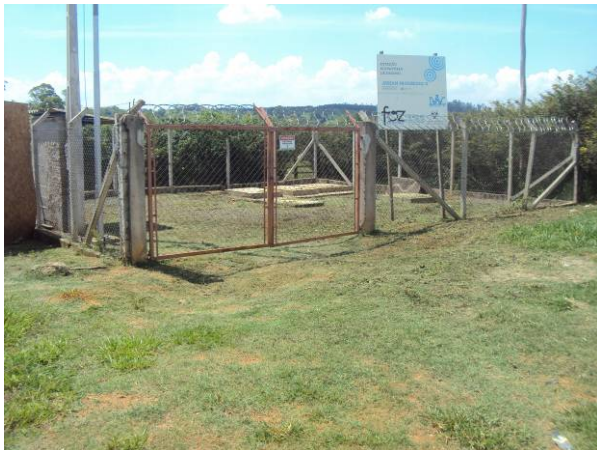
Figura 3.3.48. Vista da EEE Progresso II
