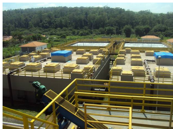
Figura 3.3.70. Vista dos Reatores UASB
