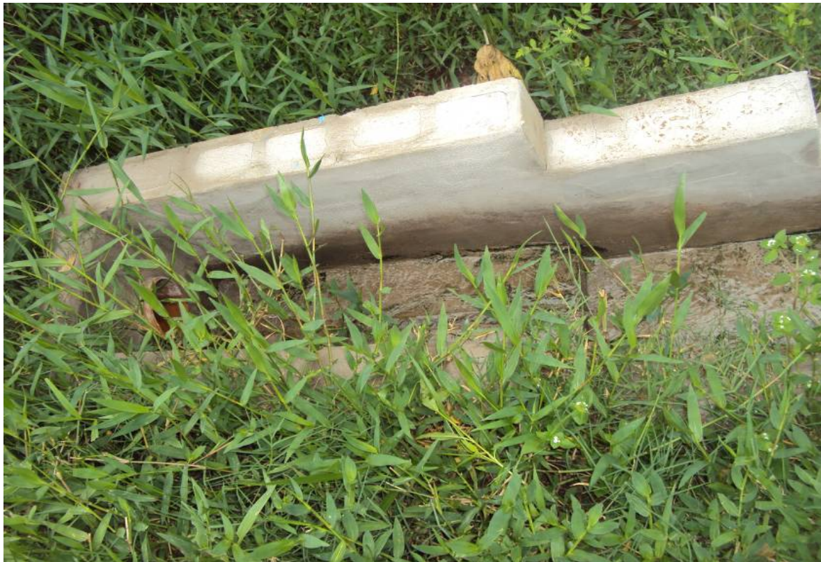
Figura 3.3.129. Vista do efluente tratado na saída do tratamento
