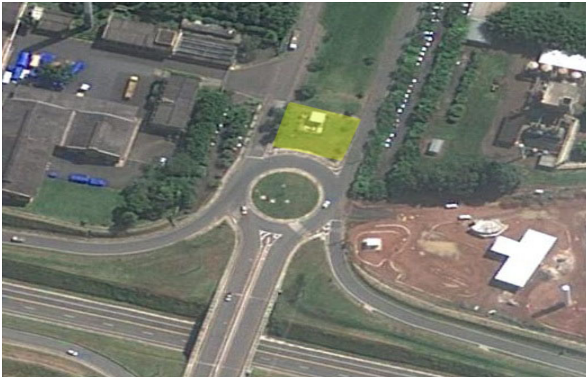
Figura 3.3.81. Vista do Local da EEE Trevo
