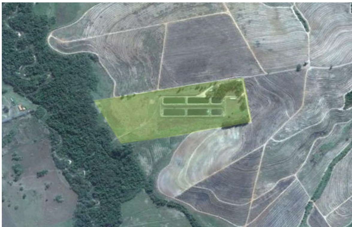
Figura 3.3.94. Vista da ETE Ajapi
