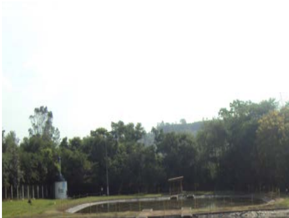
Figura 3.3.13. Lagoa de Decantação
