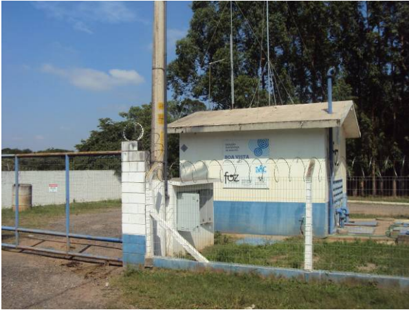
Figura 3.3.54. Vista da EEE
