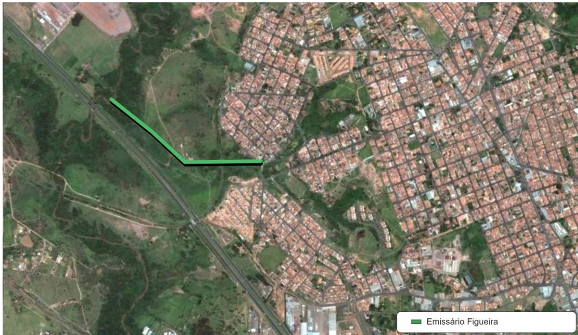
Figura 3.3.142. Vista do Emissário Figueira até o Rio Corumbataí
