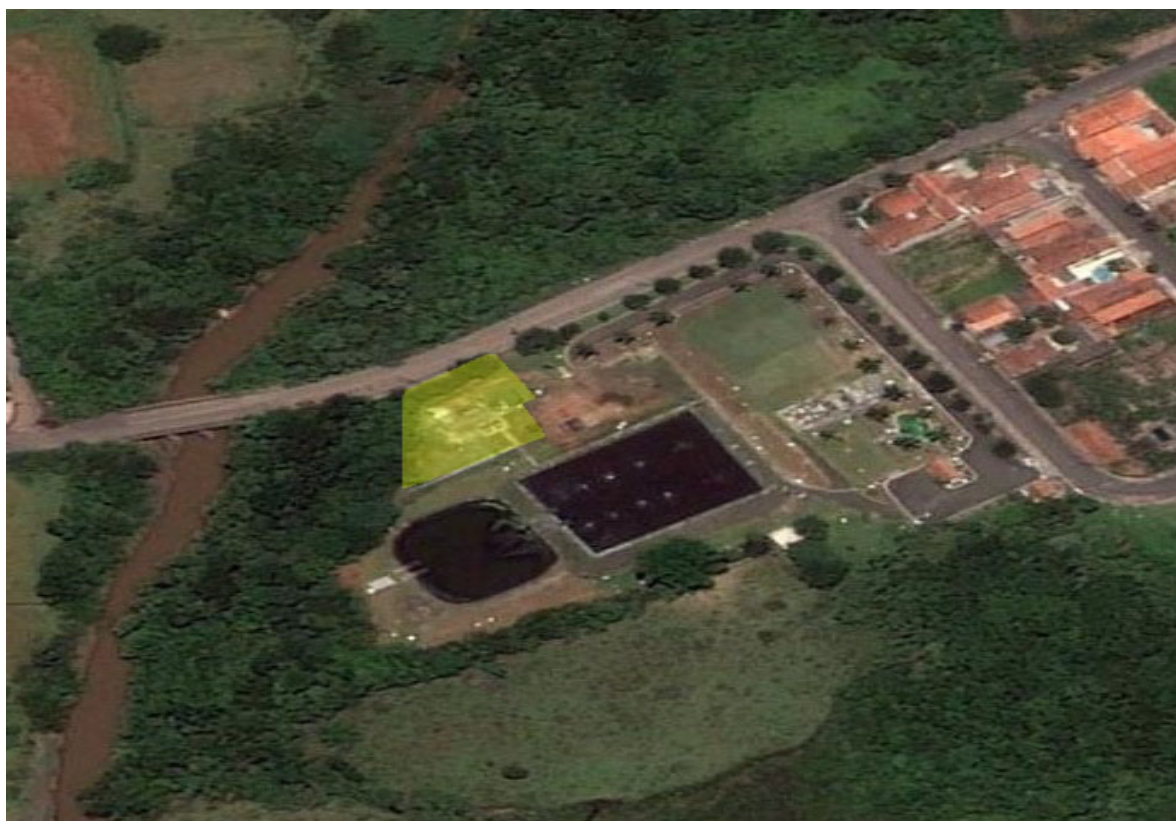
Figura 3.3.15. Vista da EEE Palmeiras, dentro da ETE Palmeiras
