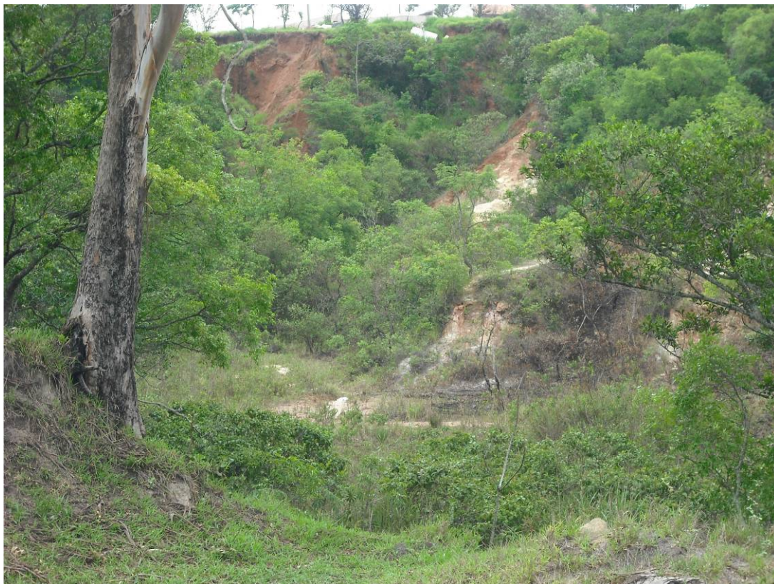
Figura 3.1.43. Vista da Voçoroca no Bairro Mãe Preta
